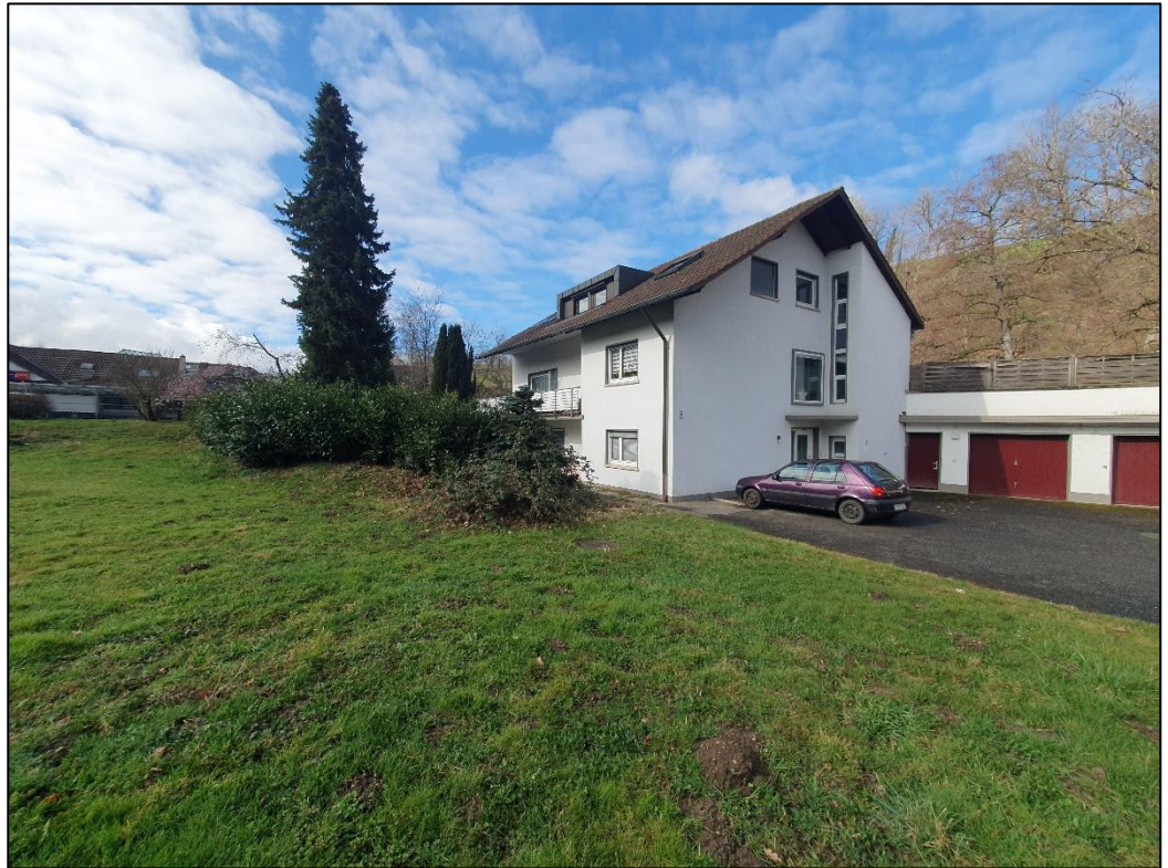
Abbildung 9: Blick auf Gebäude Dorfstraße 8 in Richtung West
