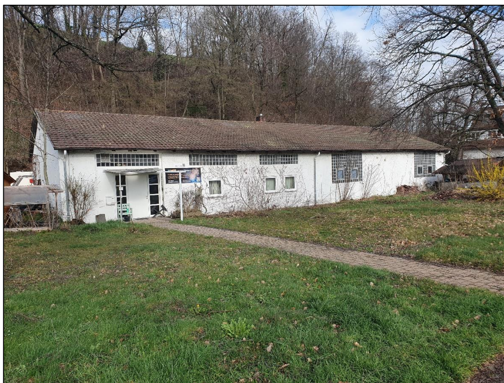
Abbildung 8: Blick auf Gebäude Dorfstraße 10 in Richtung West
